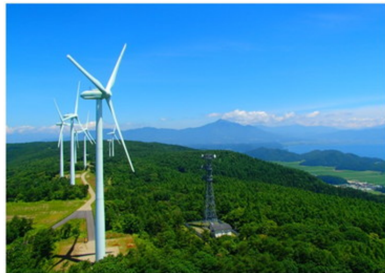
横浜野村ビルが調達している再エネ電力の発電所「会津若松ウィンドファーム」
