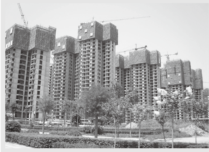
図5 宝鷄市郊外で進むマンション建設
