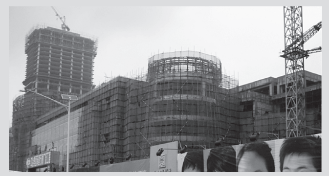
図10 建設中のショッピングセンター（河北省保定市）
