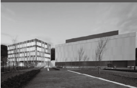
大阪第二データセンターの外観
