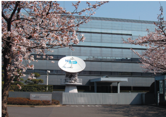
野村総合研究所 日吉データセンター
