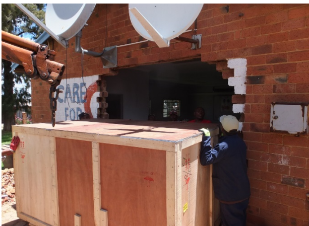
<写真5 校舎の壁を破り機械搬入>
