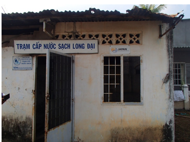
ホーチミン市 9 区浄化施設
