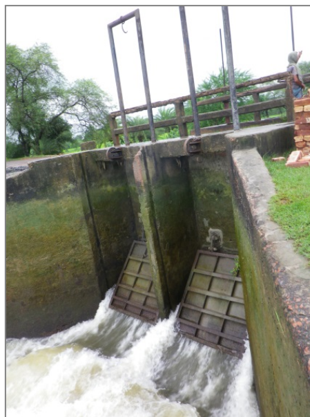
写真2 河川に設置された水門(参考)
