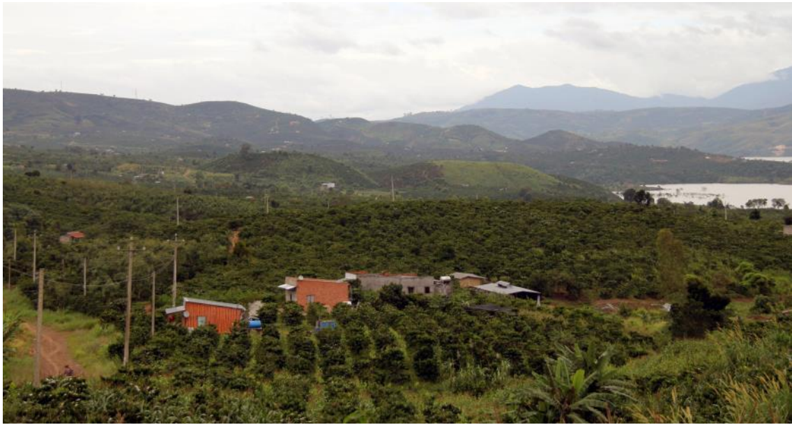
図 5-6 貯水池の周辺斜面に発生した地すべり斜面の全景
