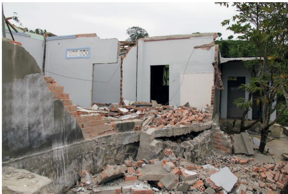
図 5-7 貯水池周辺斜面に発生した地すべりにより被災した人家施設
