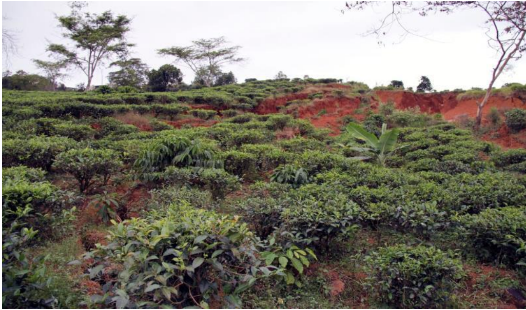
図 5-9 丘陵末端域の掘削に伴う地すべり
