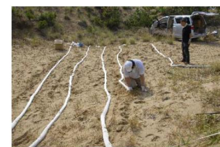
充填作業と設置が同時進行
