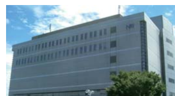
Osaka Data Center
