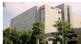
Yokohama Data Center
