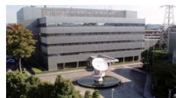
Hiyoshi Data Center
