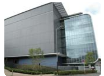
Yokohama Data Center 2
