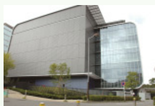
Yokohama Data Center 2
