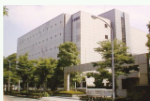
Yokohama Data Center 1
