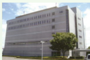
Osaka Data Center
