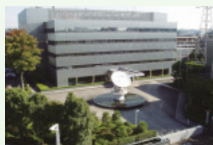
Hiyoshi Data Center
