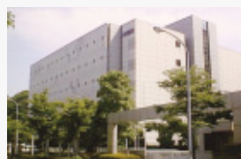
Yokohama Data Center 1
