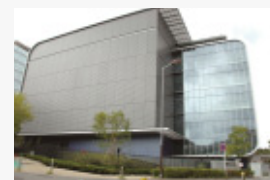
Yokohama Data Center 2
