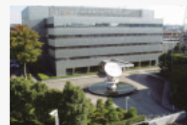
Hiyoshi Data Center
