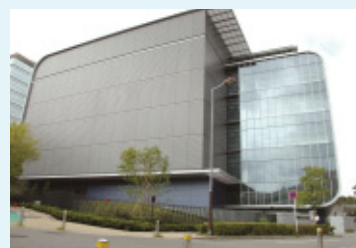
Yokohama Data Center 2
