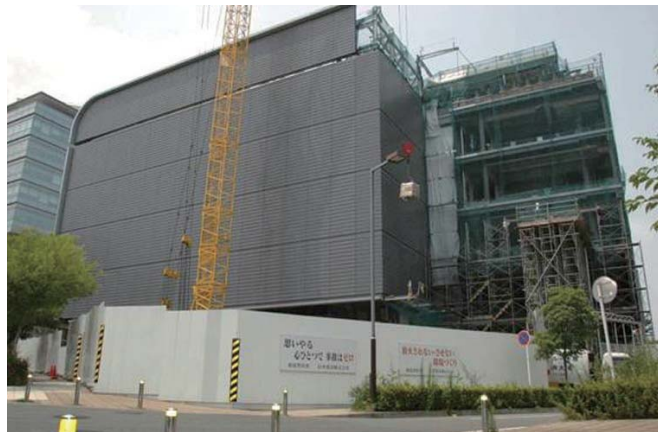
今秋完成予定の新データセンター
