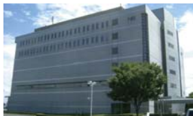
大阪データセンター
