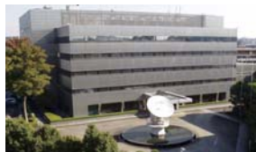
日吉データセンター
