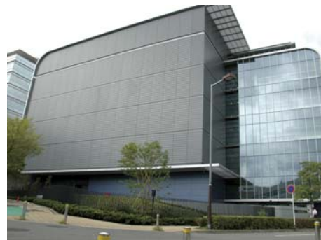
2007年10月に竣工した横浜第二データセンター
