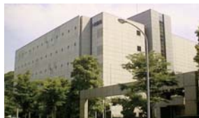
横浜第一データセンター
