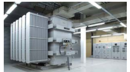
停電時でもシステムを稼働させるための電源設備
