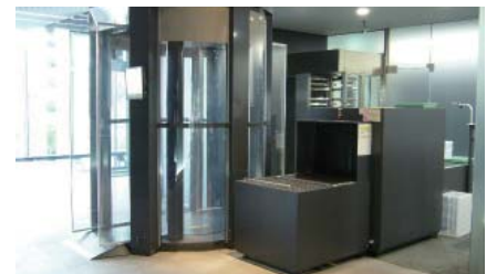
データセンターでの入退館時や搬入出時の物品検査には、3DホログラフィックスキャナーやX線検査装置を活用
