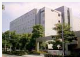
横浜第一データセンター
