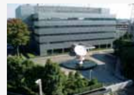
日吉データセンター
