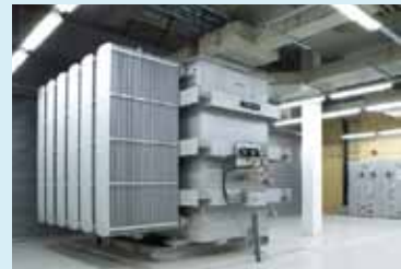
停電時でもシステムを稼働させるための電源設備
