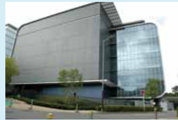
横浜第二データセンター
