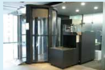
データセンターでの入退館時や搬入出時の物品検査には、3DホログラフィックスキャナーやX線検査装置を活用
