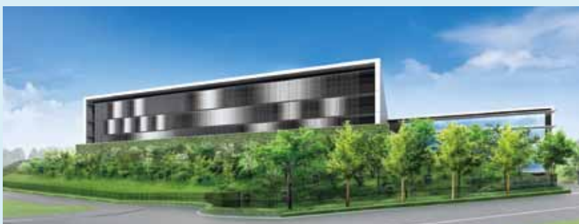
多摩市に2012年竣工予定の新データセンター
