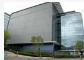
横浜第二データセンター
