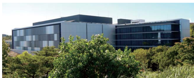
東京第一データセンター
