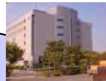
大阪データセンター
