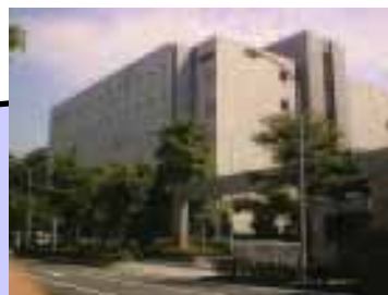
横浜データセンター
