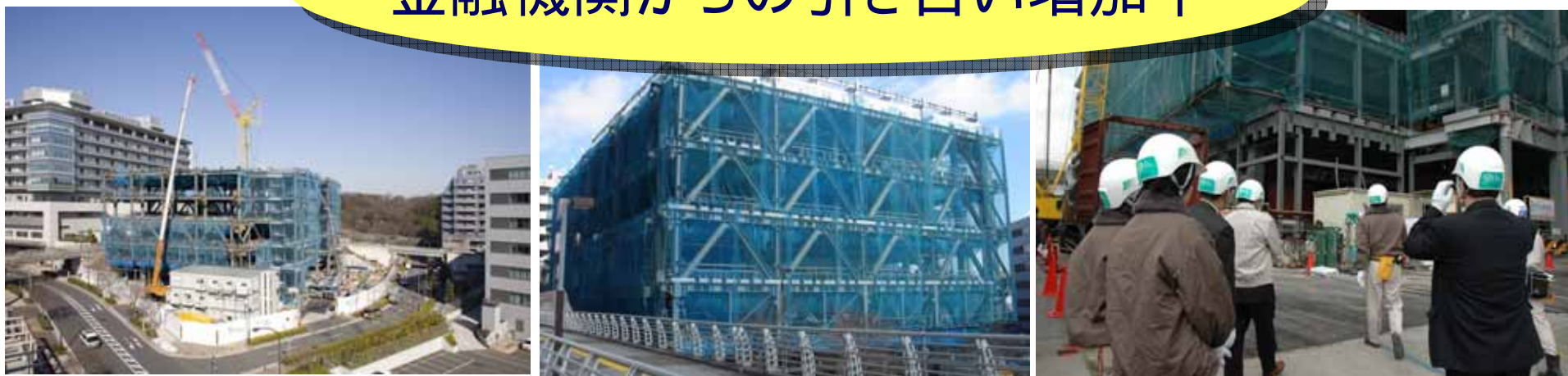
建設中の新データセンター
