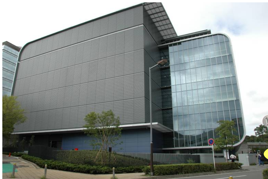
周辺環境を考慮し、圧迫感のないデザインを採用した新データセンター外観
