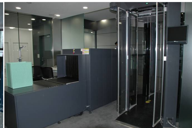
厳重なセキュリティチェック設備
