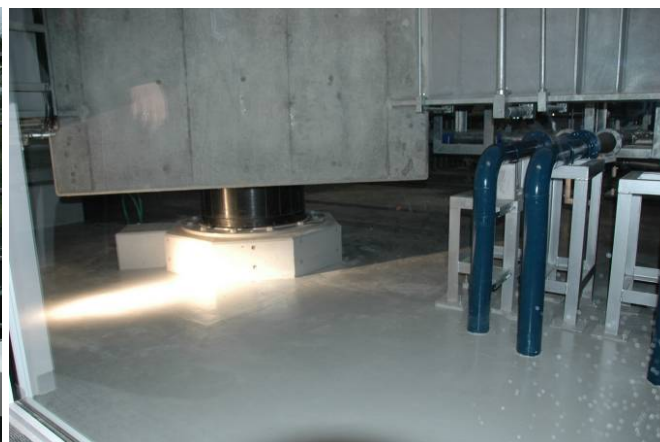
当データセンターの誇る免震構造
