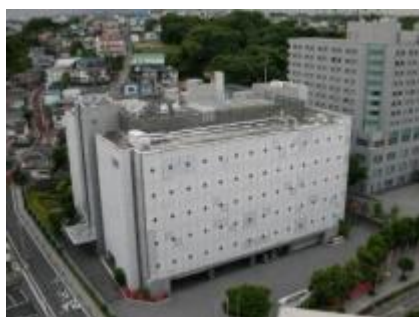
横浜第一データセンター (竣工)1990年
