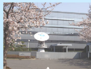
日吉データセンター
