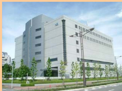
大阪データセンター
