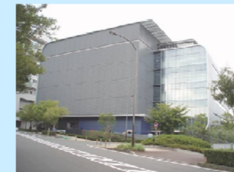
横浜第二データセンター
