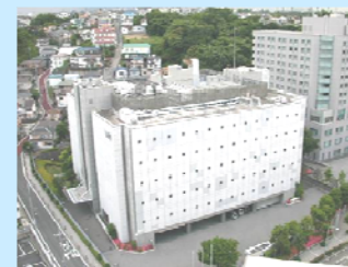
横浜第一データセンター
