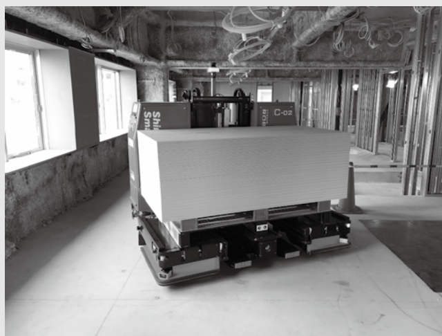
図11 建設業における移動ロボット
