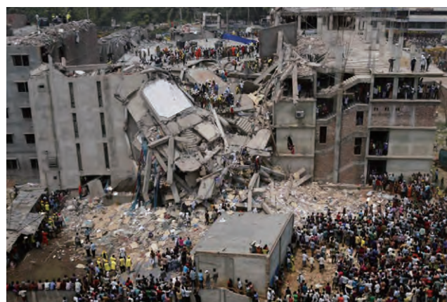
図2 ラナプラザ崩落事故
